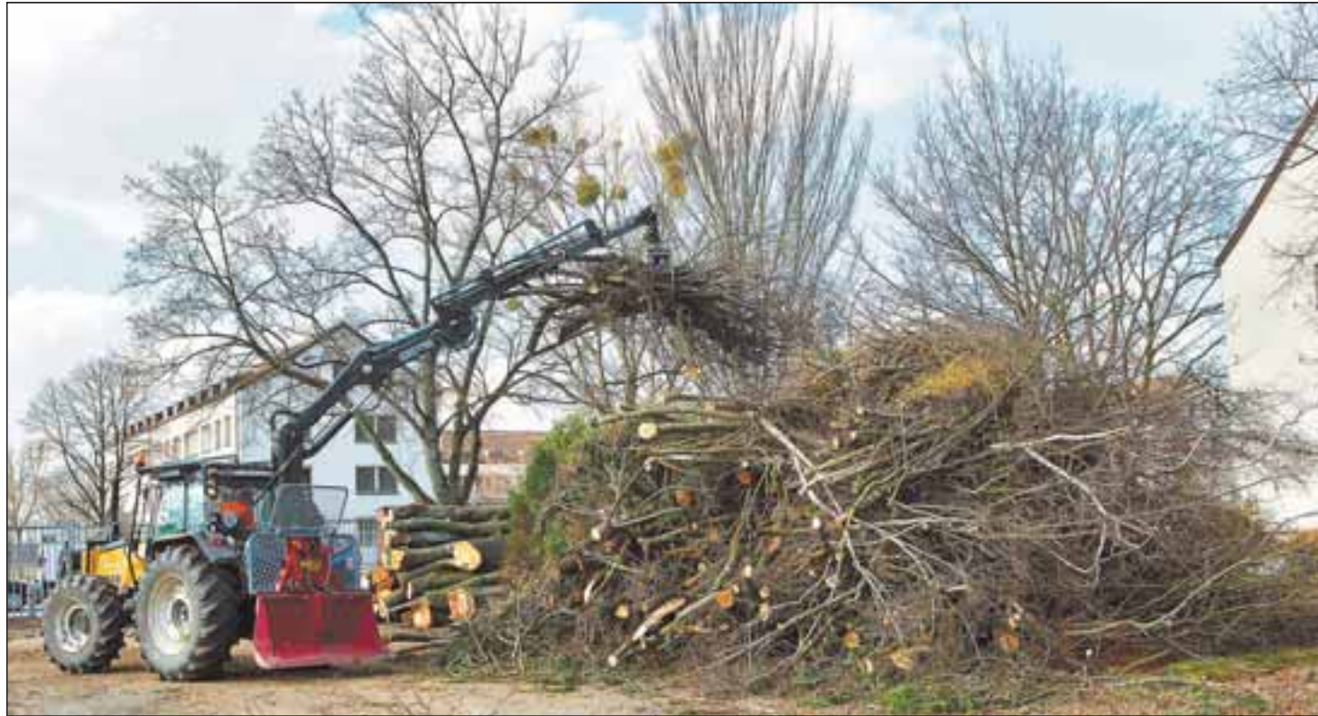
Erste sichtbare Arbeiten im neuen Wohnquartier in der Südstadt: In der Columbusstraße werden Bäume gefällt. Foto: Alex
